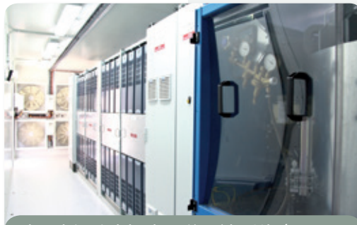
Volante de inercia de la subestación Mâcher 66 kV (Lanzarote, España). Foto cortesía de REE | Flywheel at the Mâcher 66 kV substation (Lanzarote, Spain). Photo courtesy of REE
