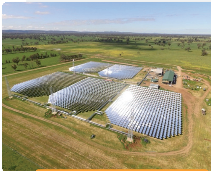
Planta termosolar de demostración de Jemalong, Nueva Gales del Sur, de 6 MW térmicos. 5 campos con torres receptoras inclinadas, tuberías de interconexión y bloque de potencia al fondo | 6 MWt CSP demo plant in Jemalong, NSW. 5 fields with tilting receiver towers, interconnection piping and the power block in the background
