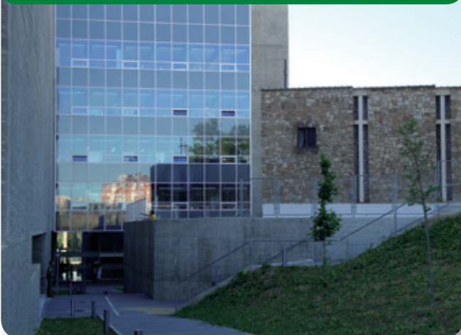
Imagen 2. Edificio tercer Milenio. Fuente: Consejería de Fomento, Vivienda, Ordenación del Territorio y Turismo. Gobierno de Extremadura | Photo 2. Third Millennium building. Source: Department of Development, Housing, Land planning and Tourism. Government of Extremadura
